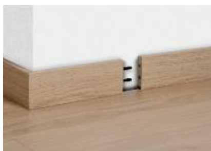
Spojení dvou soklových lišt podél zdi
