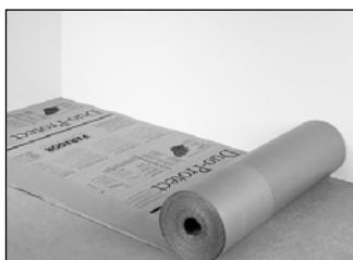
Vyložit podložky na připraveném podkladě.
