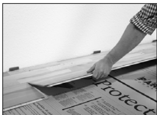
Další řada se začne opět zleva. Zaklikejte palubky po podélné straně do sebe. Lepení palubek není potřeba.
