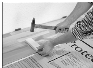
Doražte zakončení pomocí kladiva a ochrany proti úderům dohromady. Podélná a koncová zakončení se přitom uzavřít. Pokládka může pokračovat v celém prostoru.
