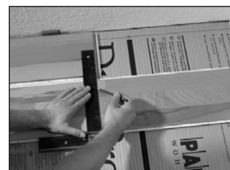
Poslední palubka první řady se zkrátí při dodržení odstupe od zdi na potřebnou délku. Odříznutý kus palubky se použije jako počáteční kus druhé řady.
