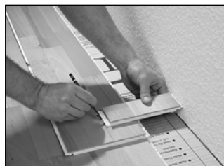
Pomocí zbylého kousku se přenesne průběh zdi na poslední řadu palubek.
