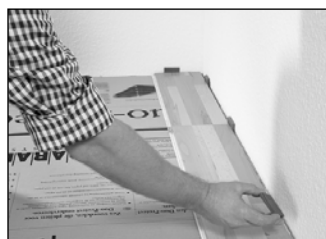
Určit/změřit pokládací plochu a první řadu palubek upravit zaříznutím.
