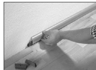
Okrajové mezery zakrýt odpovídajícími podlahovými lištami z rozsáhlé nabídky z rozsáhlého sortimentu Parador.
